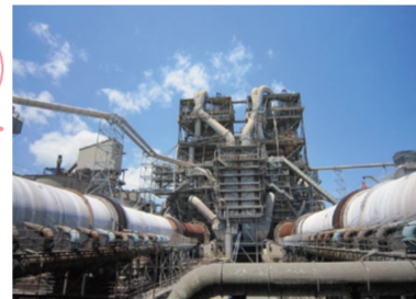
▲高さ80m、長さ100mを誇る巨大な焼成窯
