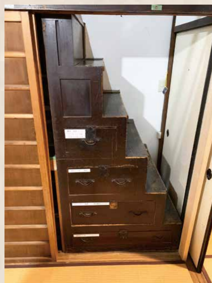
町家特有の箱階段。今でもこれを使用しているが、一方で会所自体には暑さ対策のエアコンを導入している。(霰天神山会所)
